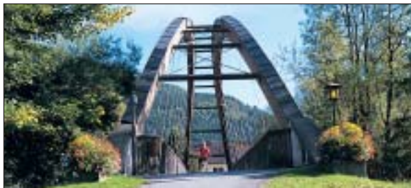
Genannt „das Tor ins Murtal“: Der Stadler Mursteg
